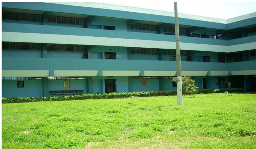
Facultad de Ingeniería Mecánica y de Energía
